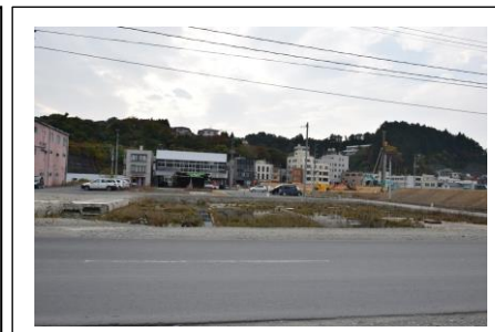
↑ 地盤のかさ上げをし始めていた
